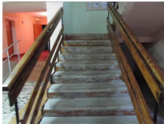
Фото №10 – Путь (пути) движения внутри здания (лестницы)
