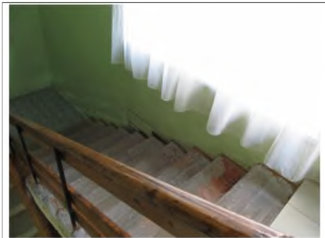
Фото №13 – Путь (пути) движения внутри здания (лестницы)
