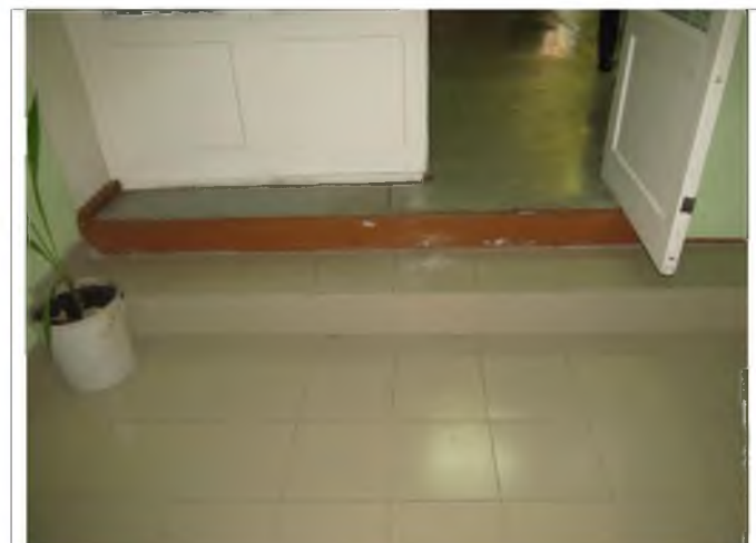
Фото №12 – Путь (пути) движения внутри здания (лестницы)
