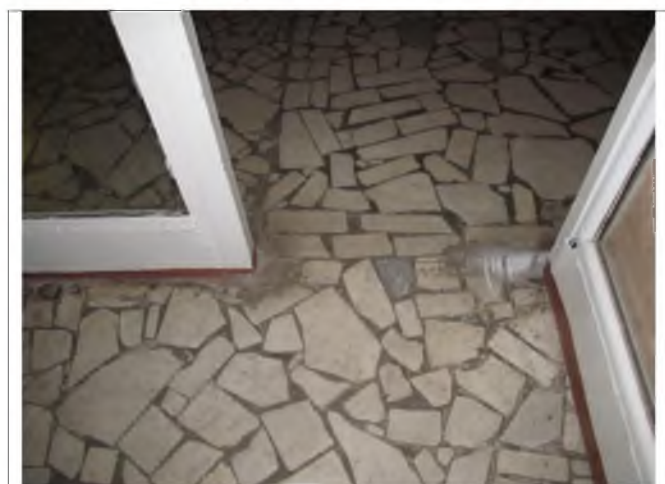
Фото №6 – Внутренняя входная дверь
