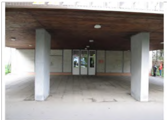
Фото №3 – Входная площадка
