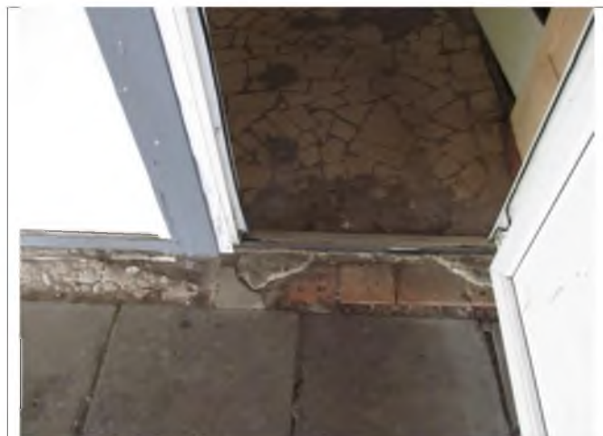
Фото №4 – Наружная входная дверь
